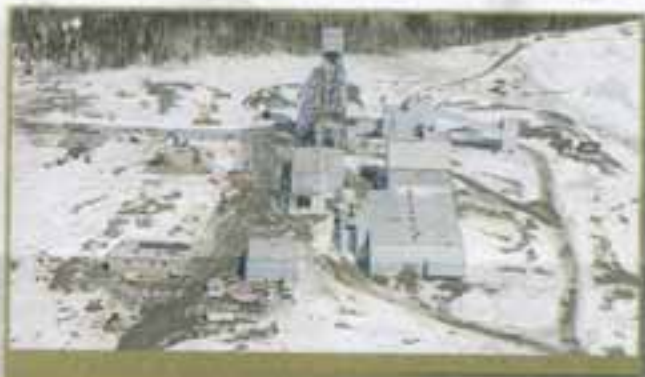
Vue aérienne des installations de la mine Bachelor
